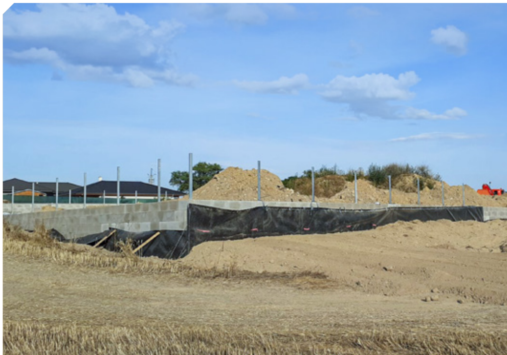
Stavební práce zasáhly také do okolních soukromých pozemků.
