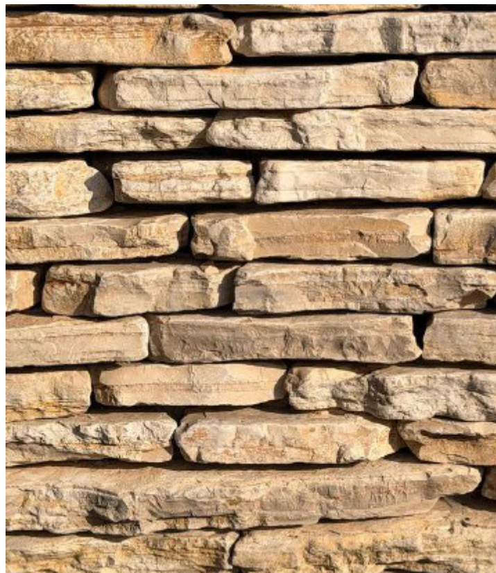
ZÍDKA PÍSKOVEC + RECYKLOVANÝ KAMEN PO BOURÁNÍ STAVBY
